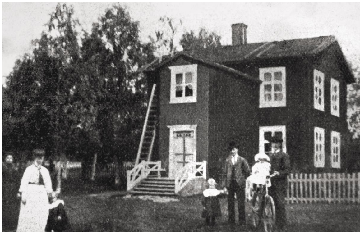
GAMLA ORGANISTGÄRDEN Å BRÄNNAN. Sedermåla lärarebostad.
