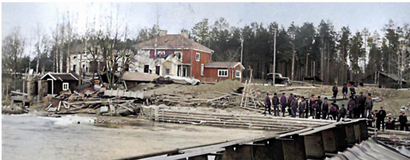
Ca 1935. Den nya laxtrappan vid Byskedammen byggdes 1934-35 I bakgrunden syns läkarbostaden byggd 1933-34, Den revs hösten 1974. T v bakom björkarna syns den gamla läkarbostaden under rivning (Skellefteå museum, färglagd)
