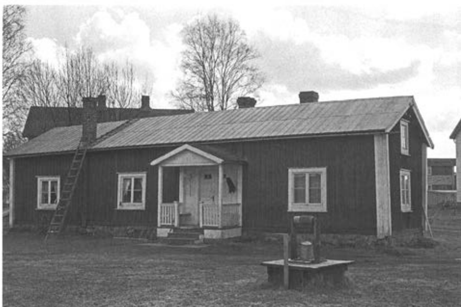
Foto 98. Den gamla garvargården som flyttades 1964 till Kyrkholmen. Gården är uppförd 1748, och har en tillbyggd införkammare från 1835. Rummet ligger innanför köket.
