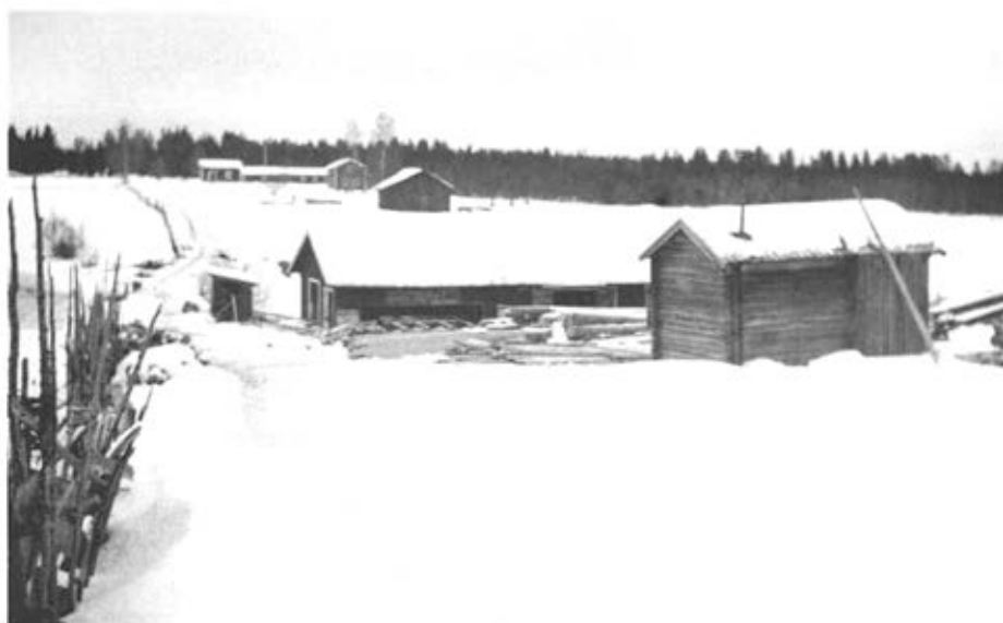
Foto 134. Nyland med sågen i förgrunden där Bondhammars järnbruk började byggas upp, 1923-24. Foto: Ernst Westerlund.
