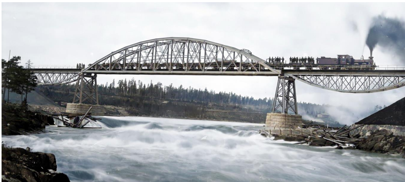
1898 Järnvägsbron över Skellefteälven vid Kusfors på linjen mellan Bastuträsk och Jörn med ett tåg på väg mot Jörn (Järnvägsmuseet, färglagd)
