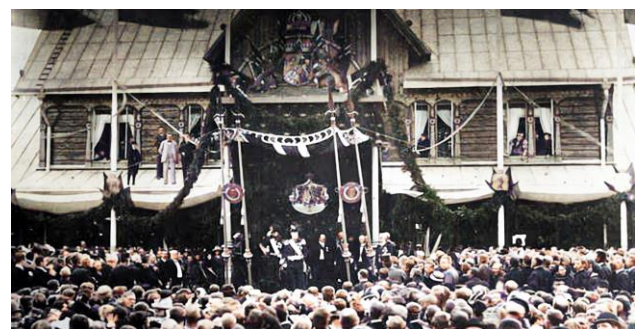
1894-08-02 Oskar II inviger stambanan Vännäs-Boden med ett tal på Bodens station (Digitalt museum, färglagd)
