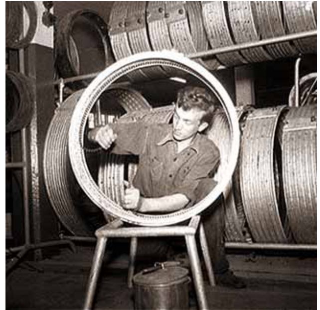
Gösta Johansson monterar in stålspiralen som ska vulkas in i däcksmönstret enligt Wiresoles-patentet (foto Wollmar Lindholm).
