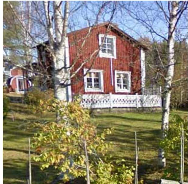
Huset på Yttergatan 39 är kvar än idag insprängt bland nya villor (foto Stig Sandström).
