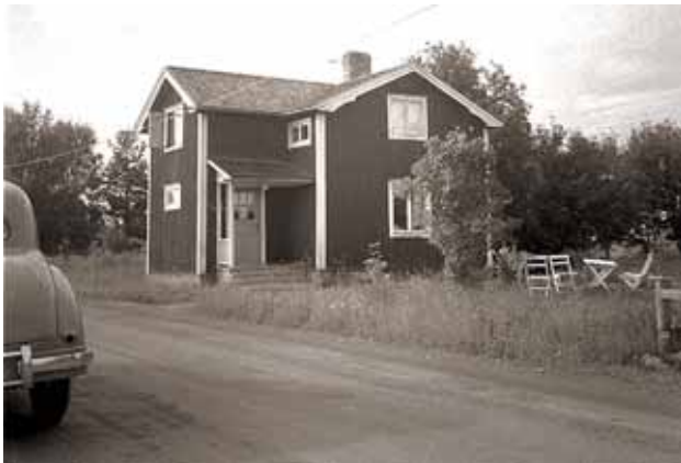
Fotot av Tekla Karlbergs och senare Tore Sandströms hus är förmodligen från 1953.
