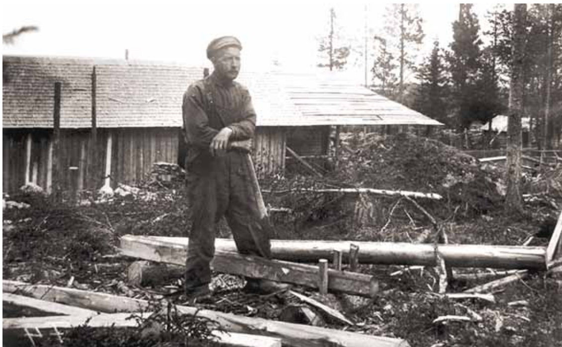
1923 Johan Westerlund ('n Janne, 'n JO) håller på och bilar, planhugger in- och utsida på en stock som vilar mellan två tappar. Stockarna skulle användas för att bygga på ladugården på Lennart Westerlunds nuvarande gård på Södra Ersmark 460 (foto Ragnar Jirlow).
