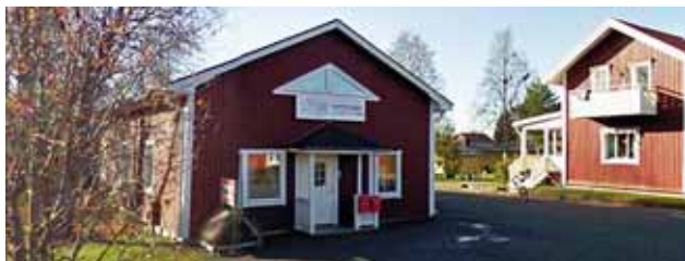
2016. Kontorslokalerna på Ersmarksvägen 38. Bostadshuset är till försäljning (foto Stig Sandström).
