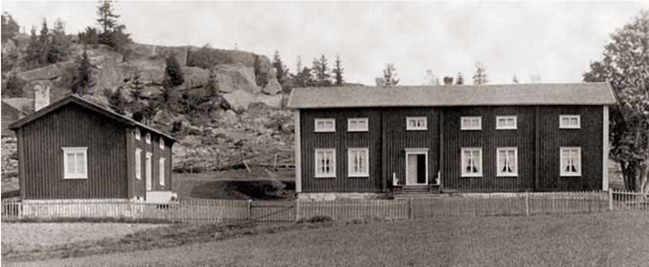
Ca 1940. På Kalista-gården har brotaket ännu inte kommit till (foto Ernst Westerlund).
