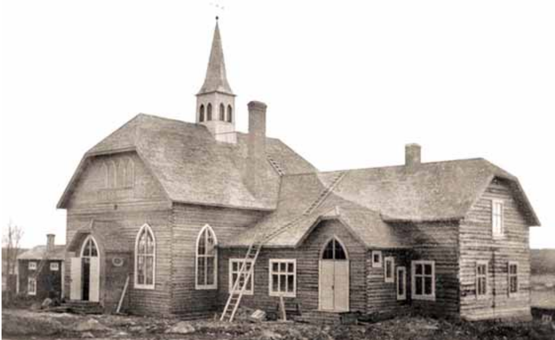
Ovan bild från byggtiden 1922 (källa Jakob Jakobsson) och nedan efter invigningen 1923 (foto Okänd).
