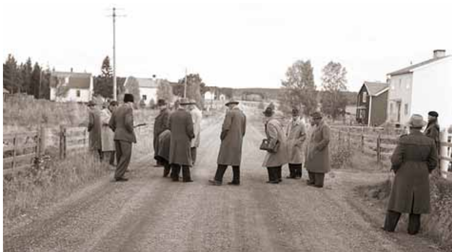
Häradsrätten besöker olycksplatsen 1952-09-23. Man tittar mot öppningen i staketet där Nils kom och man tittar mot Kåge varifrån olycksbilen kom (foto Nordsvenska Dagbladet)
