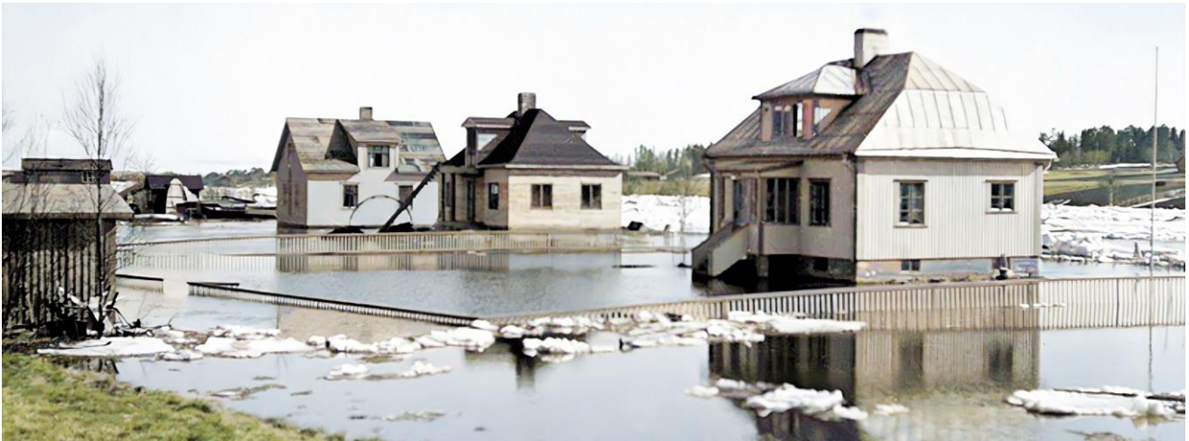
6/5 Tuvagårdsvägen 74 och 76 i Norra Tuvan. Ett flertal villor i Tuvan och Hedensbyn blev kringflutna av vatten och de inneboende måste ta sig till "fastlandet" per båt (Skellefteå museum/NV, färglagd)
