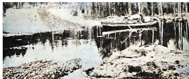
7/15 Ljusvattensvägen under vatten. En båt färjade över gående medan en del bilar kunde ta sig över (Skelleftebladet, färglagd)
