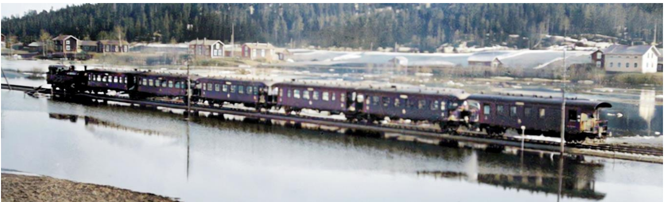
6/5 Mellan Morön och Bergsholmen stod banvallen på en sträcka av 1 km under vatten och tågen fick framföras med försiktighet t (Skellefteå museum/NV, färglagd)
