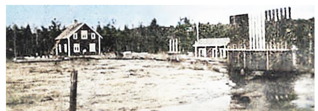
16/5 Hotad kraftverksdamm vid Storfallet med fallhöjden 22 m (Skelleftebladet, färglagd)
