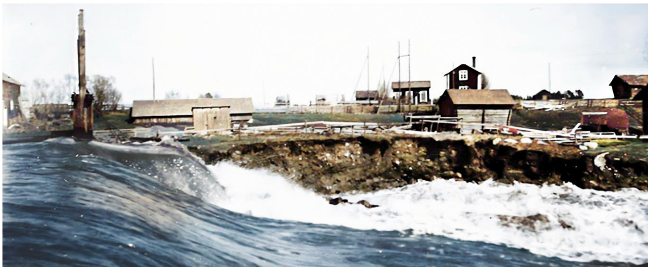
12/5 Holmfors kraftstationen vid nuvarande skolan var hotad och maskineriet har stannat. Det befarades att Holmforsbron skulle föras ut i havet (Skellefteå museum/NV, färglagd)
