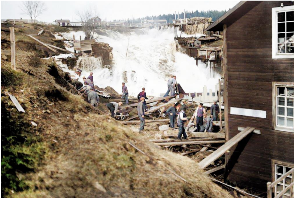
12/5 En skyddsmur håller på att uppföras och gjutas vid Bröderna Nordins snickerifabrik (Skellefteå museum/IV, färglagd)
